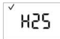
Schermata di monitoraggio gas (display di testo)
